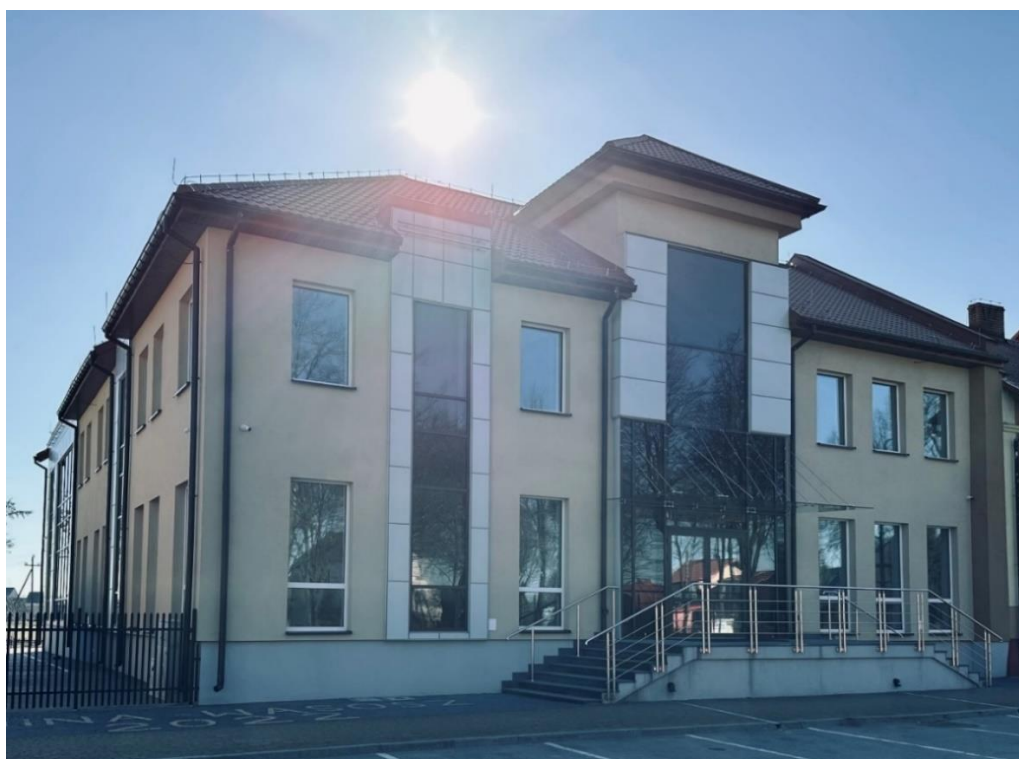
fot. Budowa energooszczędnego budynku Urzędu Gminy Wąsosz
