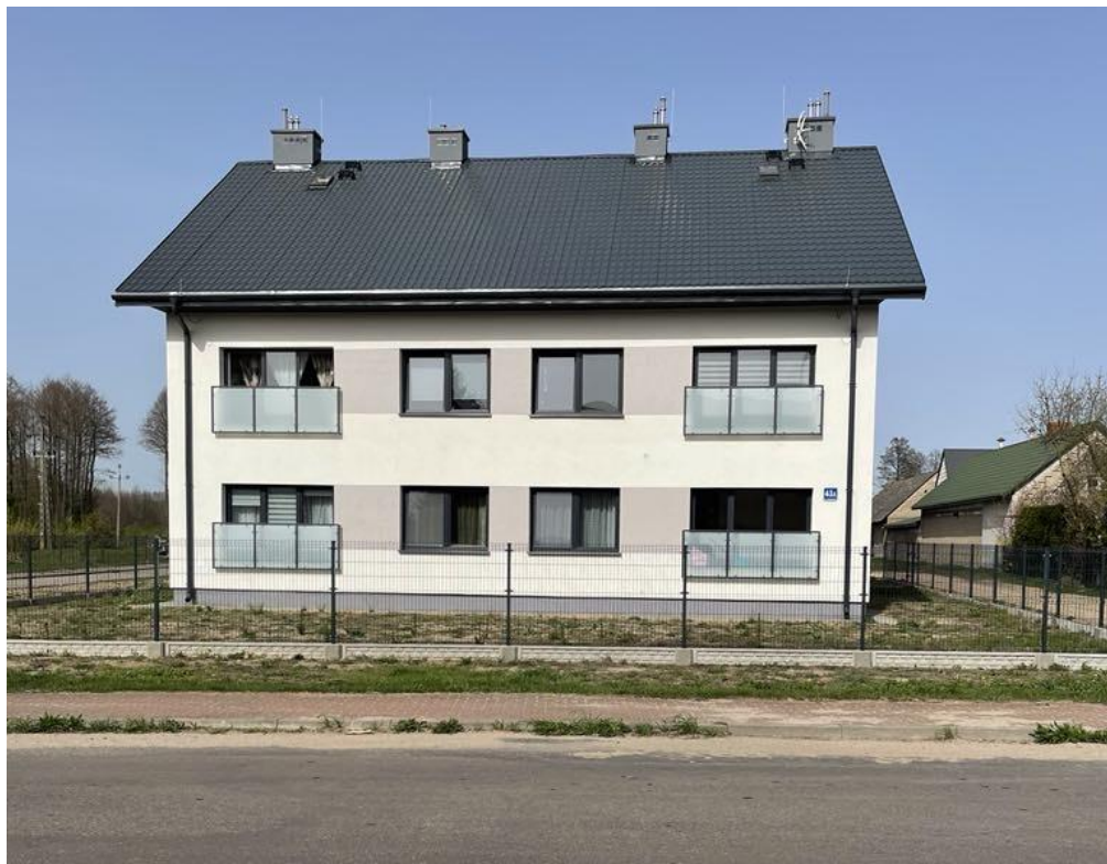
fot. Nowy budynek komunalny przy ul. Mazowieckiej w Wąsoszu
