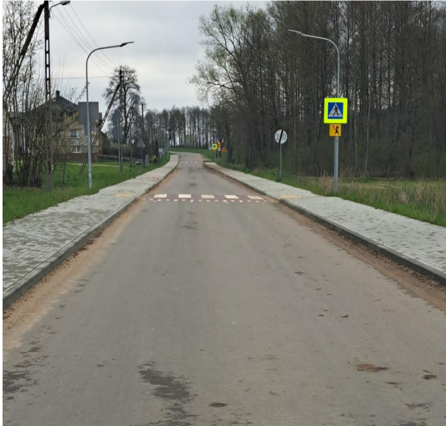
fot. Fragment drogi powiatowej we wsi Nieciki – realizacja z udziałem środków Gminy Wąsosz
