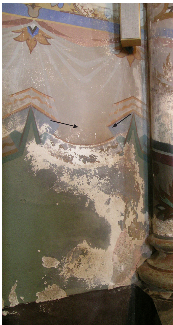
Polichromie prezbiterium. Widać mocno pudrujące się przemalowanie ponad lamperią, pod spodem widoczna ciemniejsza warstwa. Farba olejna lamperii łuszczy się, odspaja i pęka.
