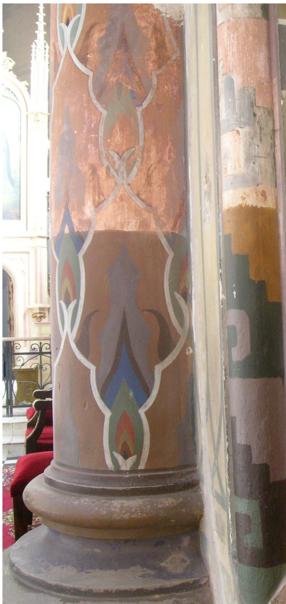
Fragmenty polichromii w dolnej partii filarów międzynawowych. Widoczne rozległe przemalowania zniszczonych fragmentów.
