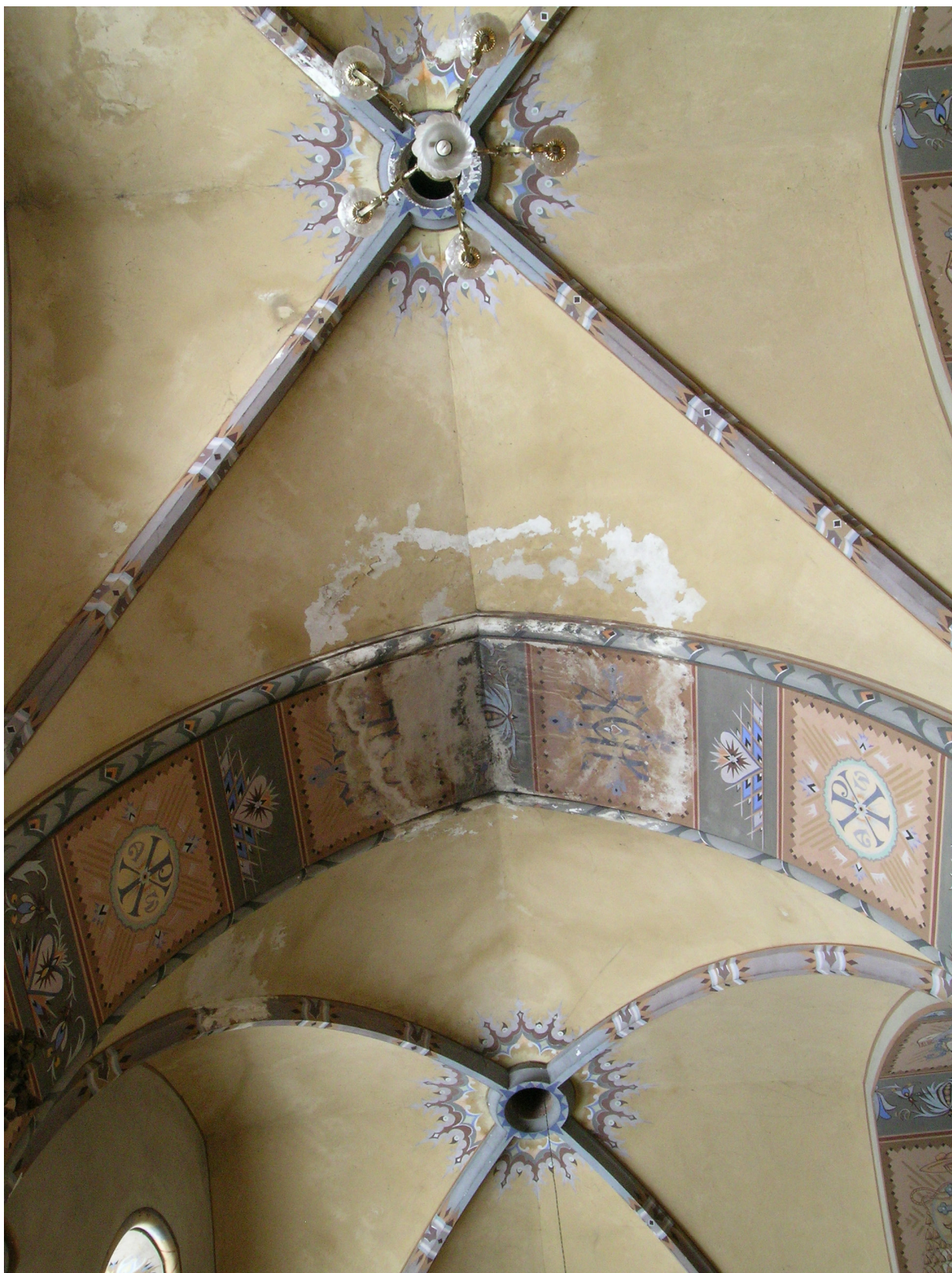
Fragmenty polichromii sklepień nawy bocznej z widocznymi zaciekami i białymi wysoleniami powodującymi destrukcję powłok malarskich.
