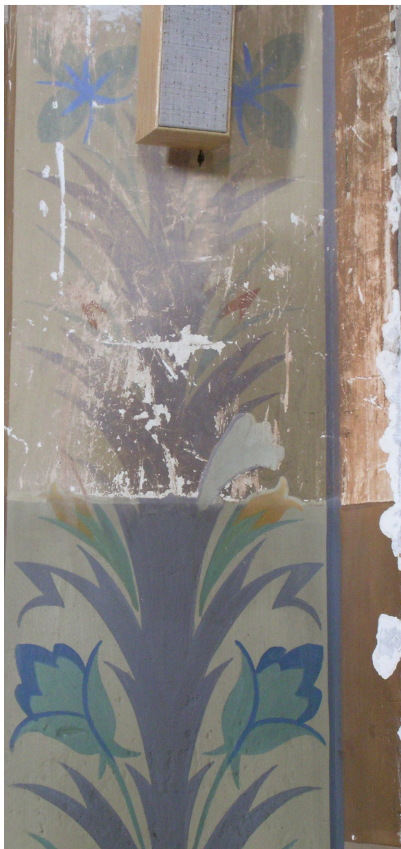
Fragmenty polichromii w dolnej partii filarów międzynawowych. Widoczne rozległe przemalowania zniszczonych fragmentów.
