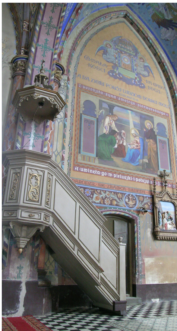
Polichromie pierwszego przęsła od zachodu ściany północnej prezbiterium. Widać mocno pudrujące się przemalowanie ponad lamperią, pod spodem widoczna ciemniejsza warstwa. Farba olejna lamperii łuszczy się, odspaja i pęka.
