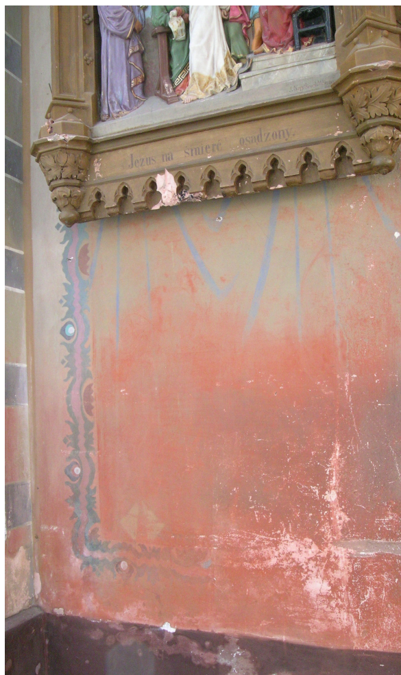
Fragmenty polichromii w dolnej partii ścian. Widoczne rozległe przemalowania i zniszczonych dekoracji malarskich. Olejne przemalowanie łuszczy się i odpada całymi płatami.
