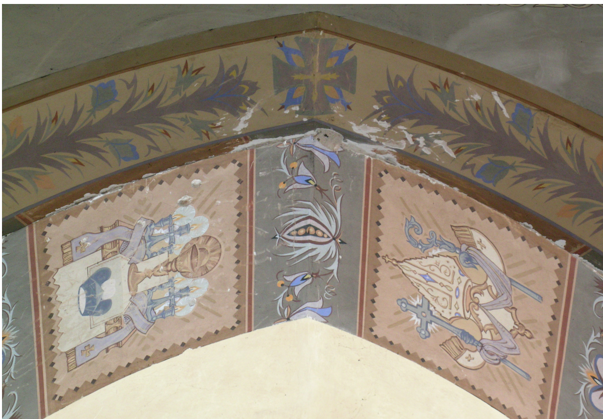
Fragmenty polichromii w zwieńczeniu łuku arkad międzynawowych. Widoczne ubytki warstwy walcarskiej.
