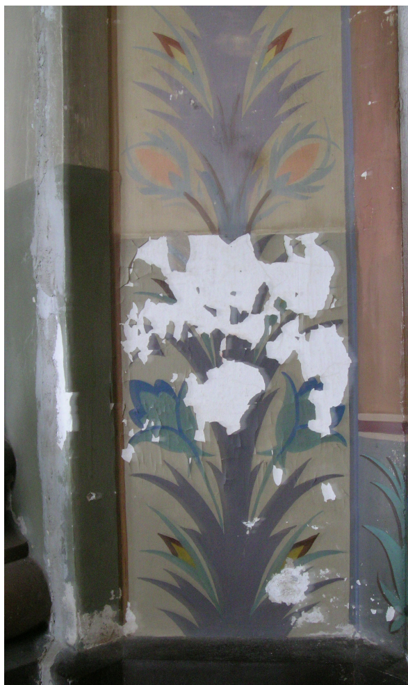
Fragmenty polichromii w dolnej partii ścian. Widoczne rozległe przemalowania i zniszczonych dekoracji malarskich. Olejne przemalowanie łuszczy się i odpada całymi płatami.
